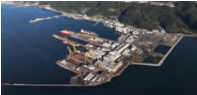
Los astilleros ASMAR de Talcahuano se han transformado en un vital polo de desarrollo industrial y naval. Destaca la grada de construcción, hoy fundamental para la política naval (foto Armada de Chile).
